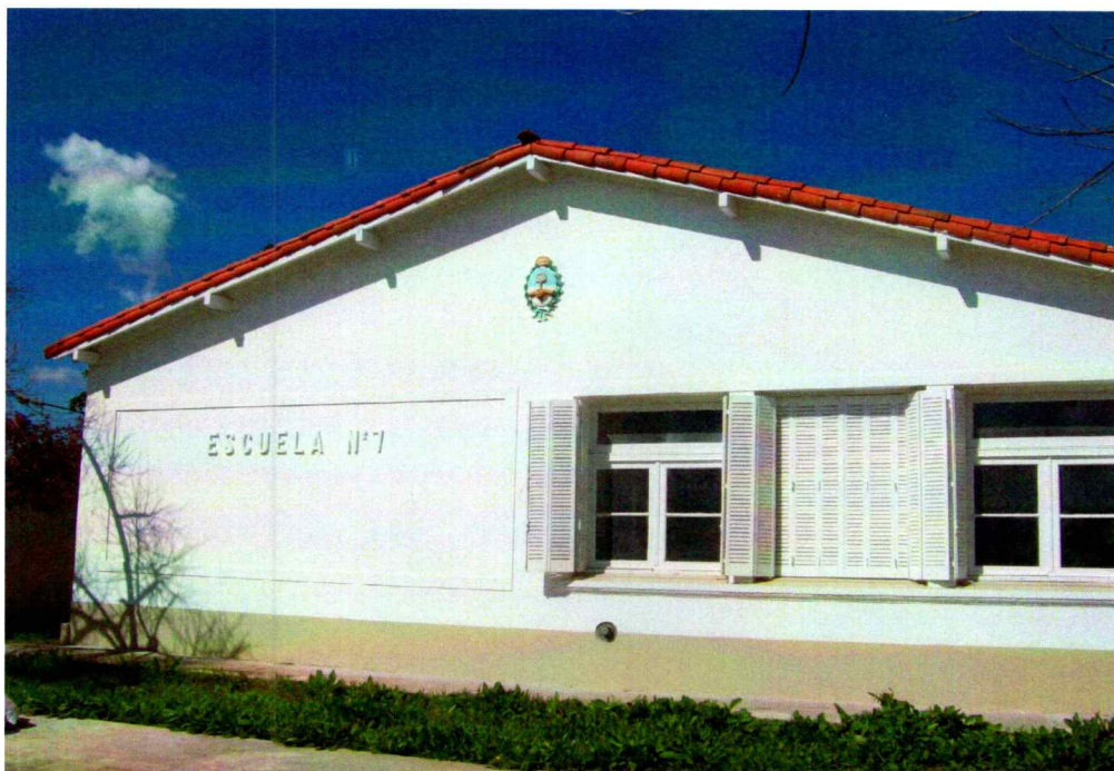
Edificio actual del CEAT luego de la restauración de la Escuela N°7
