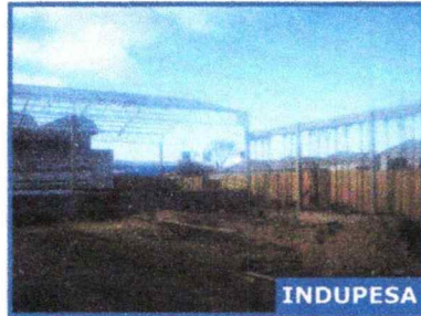
Fotos Nº 23 y 24 - Primera etapa de la construcción del muelle de descarga y cámara frigorífica.
